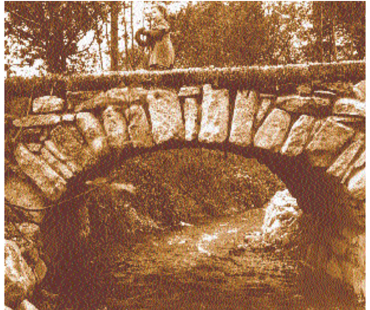
Spuren einer 100-jährigen Firmengeschichte: Bach-Bruggli im Himmelrych (1908), Bau de
